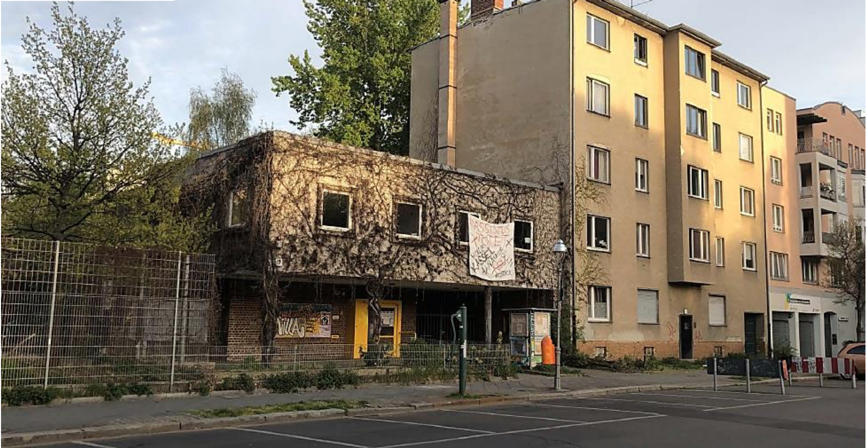
Modul 2 - Rückbau Bestandsgebäude und Spielplatz Frobenstraße 27-29
